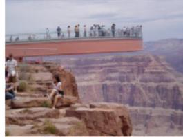
Le tablier sur lequel circulent les visiteurs repose sur deux poutres tubulaires de section rectangulaire (figure 1 et figure 2). Chaque poutre (OC) de longueur L est encastree au point O et en appui au point B sur deux barres circulaires (AB) (figure 3)
